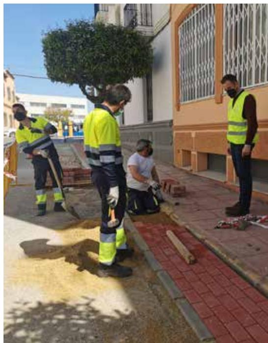
Las obras también han consistido en aplicar un nuevo pavimento asfáltico en la calzada de la parte de la calle que se encontraba más deteriorada, la construcción de nuevas aceras y la ampliación de las aceras existentes hasta una anchura mínima de 1,80 m, así como rampas y vados necesarios para evitar las barreras a las personas con minusvalía en los pasos de peatones.
